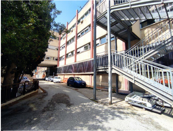
Figura 1 | Facciata ala Est
