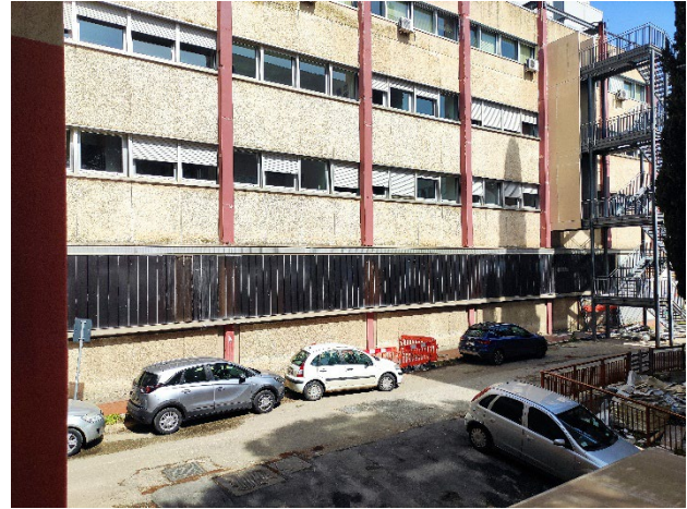
Figura 2 | Facciata ala Est
